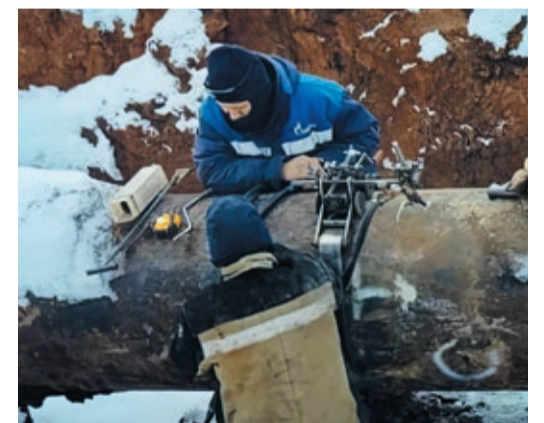
На магнитогорской трассе — сварщики из сборной бригады
