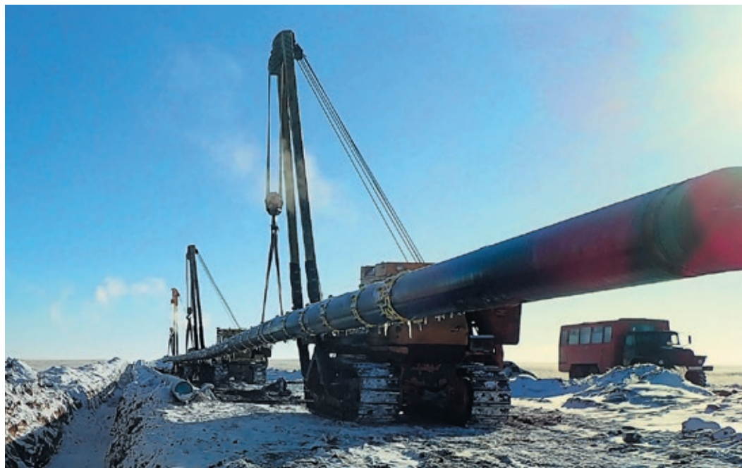
В подготовке плетей для орского отвода участвовала домбаровская ЛЭС
