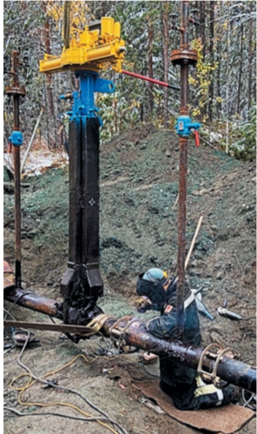
Невьянские сварщики и линтубы заменили охранный кран на отводе к ГРС «Таватуй»
