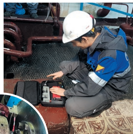
Для калибровки открывают защитный кожух ГПА, датчик устанавливают на стенд, а оператор с пультом работает в машинном зале
