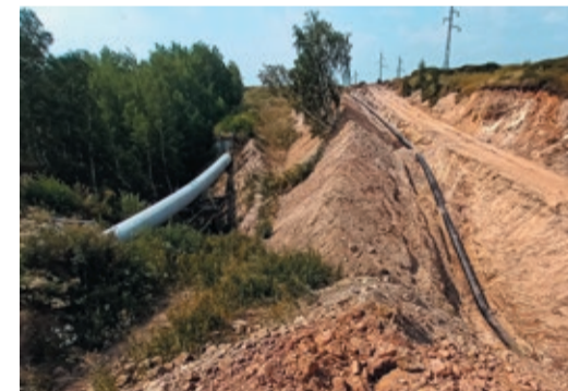
Медногорский отвод «приземлили» летом, а очередь магистрали пришла в октябре
