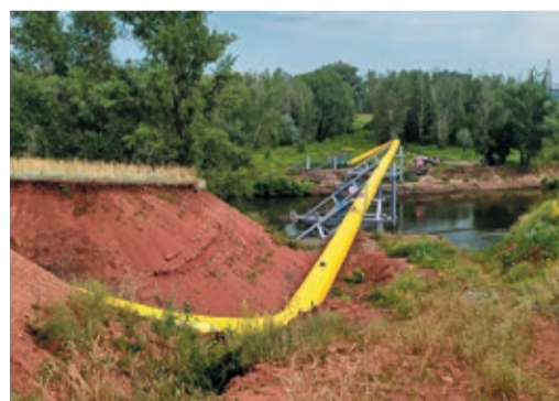
Для установки датчиков на переход через реку Сакмару приглашали альпинистов
