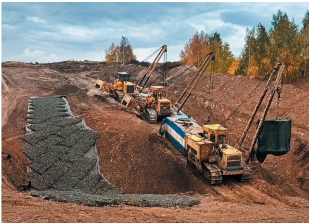
В Медногорском ЛПУМГ для защиты от паводковых вод переходы уложили в глубокие траншеи и закрыли сверху габионами
