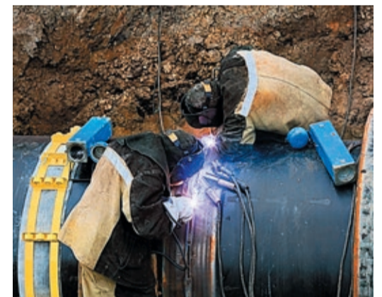
Шесть стыков сделали сварщики, чтобы собрать дюкер под автодорогой
