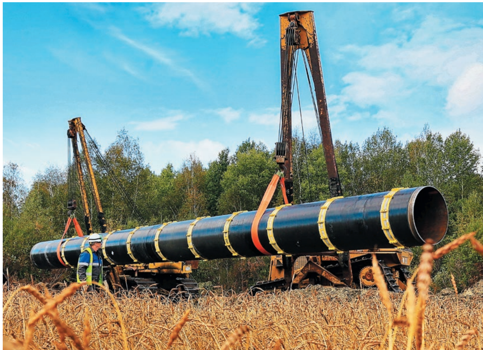
Основные ремонтные работы на переходе через автодорогу в Курганской области пришлось на короткое уральское «бабье лето»
