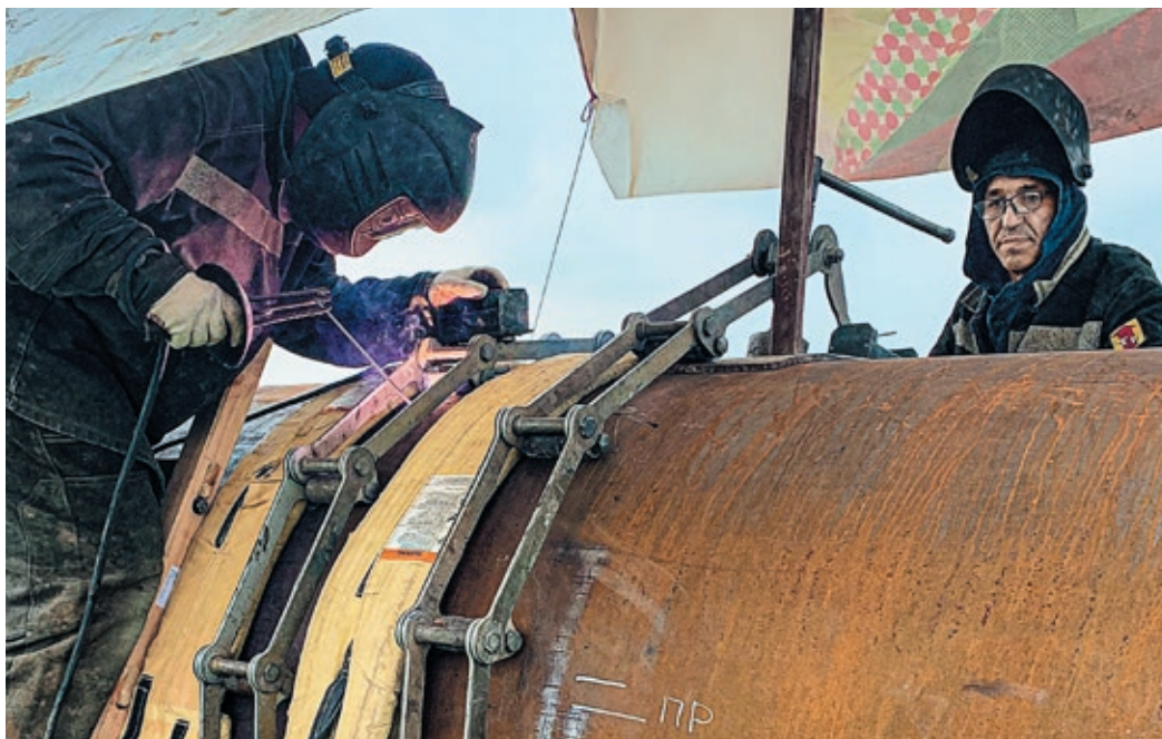
Перед началом работы стык греют индукционными нагревателями до 170–200 градусов
