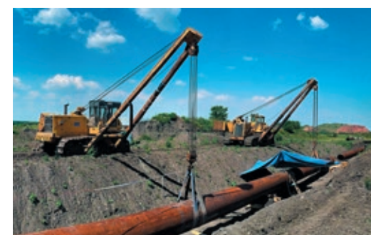
По расчетам ученых, достаточно двухсотметровой плети, чтобы сымитировать протяженный участок газопровода
