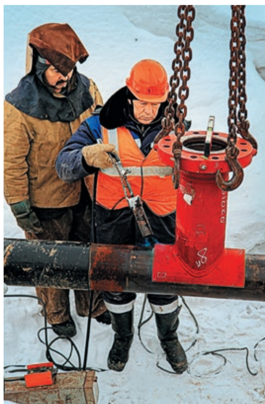
С монтажом разрезного тройника могут справиться только настоящие профессионалы
