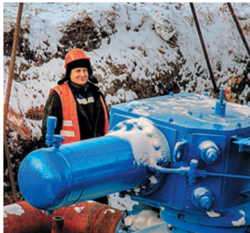
Первыми в УАВР № 1 сварочную дугу на трубе под газом зажгли Николай Хрипунов (на фото) вместе с Андреем Плотниковым
