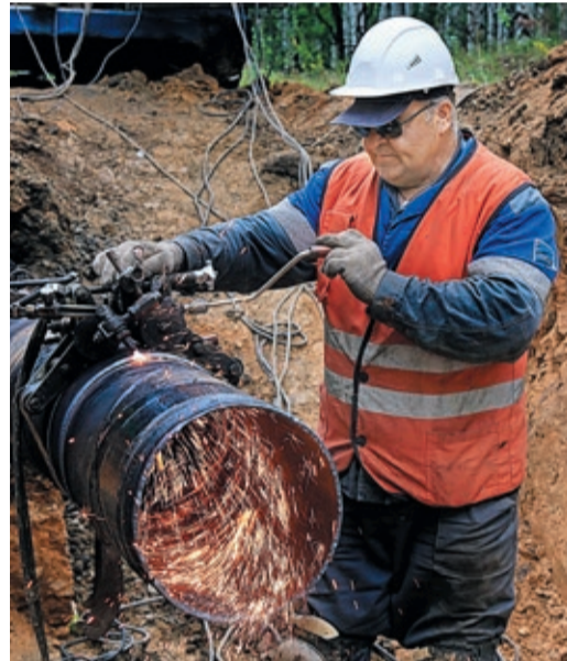
Бригадир УАВР № 2 Олег Парфенов готовится к монтажу второй за день трубы
