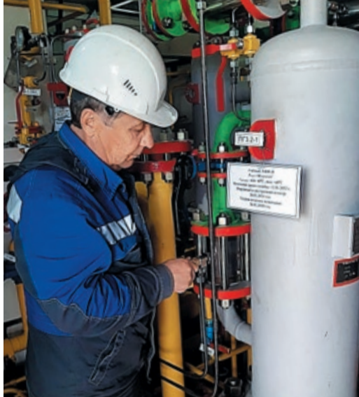
Оператору ГРС села Лабызы Юрию Чеснокову нужно проверить все узлы нового подогревателя газа
