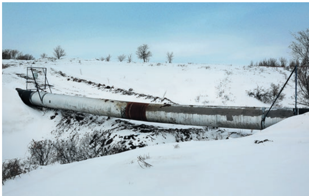
После того как в Оренбуржье потеплеет, уавровцы вернутся и нанесут на новые катушки защитное покрытие
