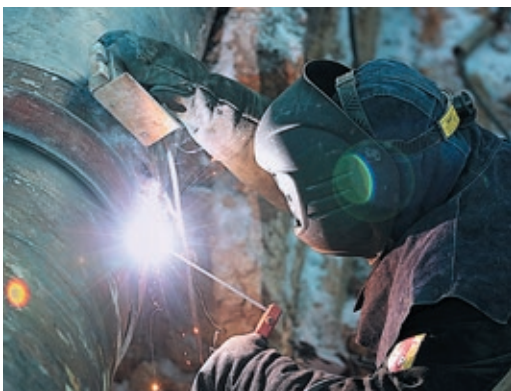
Сварные стальные муфты позволяют ремонтировать трубу, не останавливая газопровод
