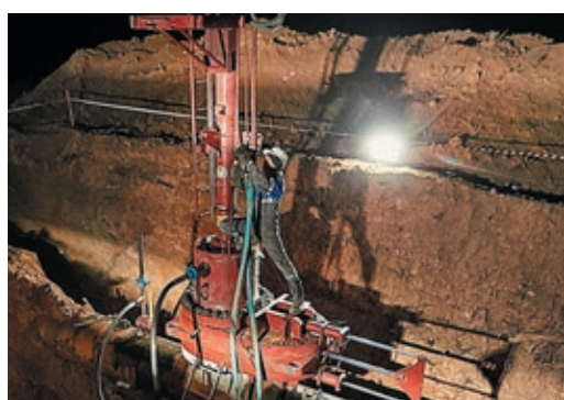
Врезка под давлением сложна технологически, но выгодна экономически и экологически
