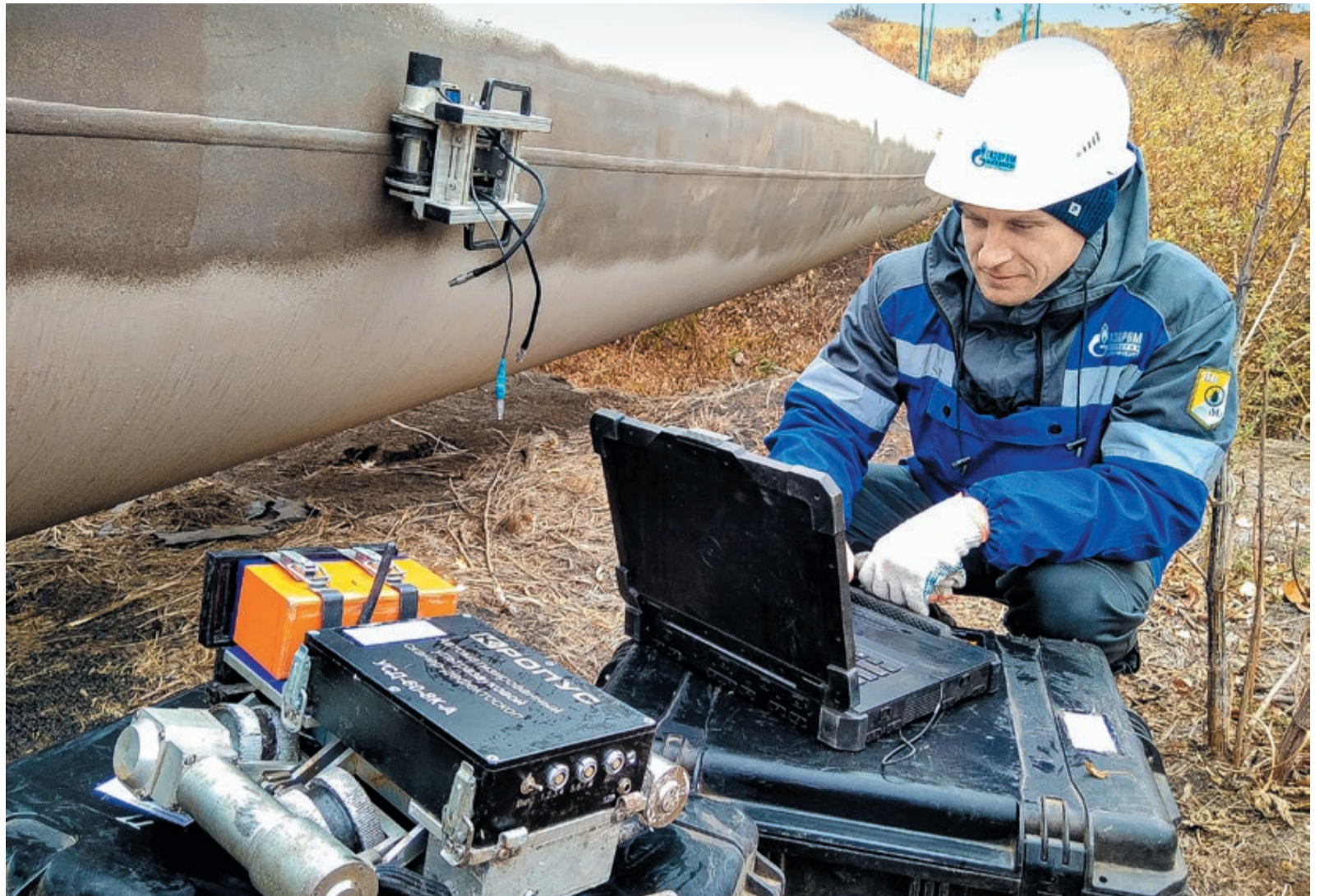
Для настройки дефектоскопа и сбора данных инженеру ИТЦ Денису Назимову не нужны провода, потому что связь с роботом осуществляется по wi-fi
