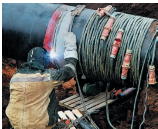
Трубы, пораженные стресс-коррозией, подлежат обязательной замене
