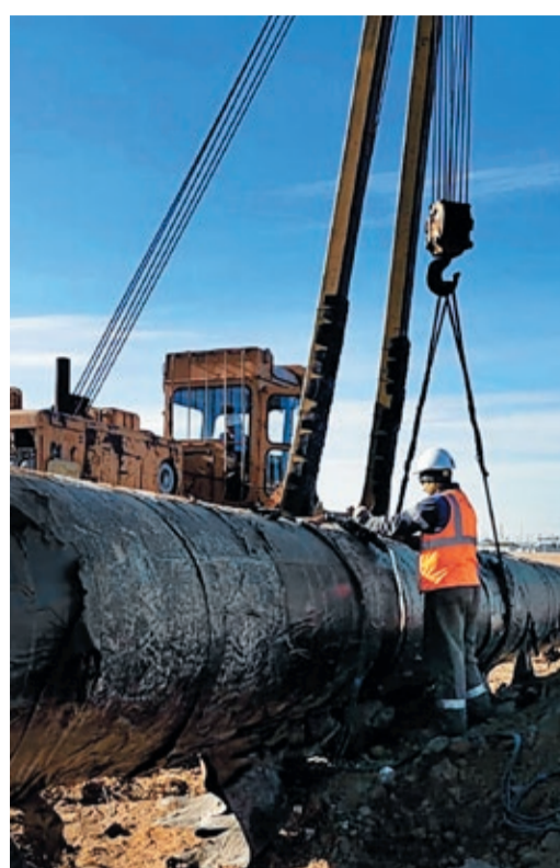
В ходе комплекса газовой заменили несколько крановых узлов и большое количество дефектных труб
