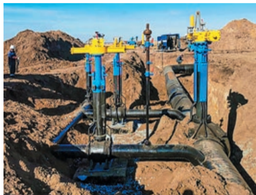
В ходе комплекса газовой заменили несколько крановых узлов и большое количество дефектных труб
