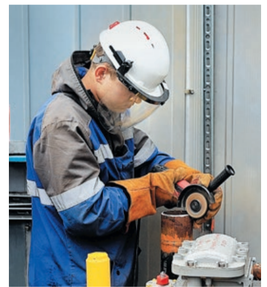
Егор Лещенко делает зачистку перед монтажом очередного элемента
