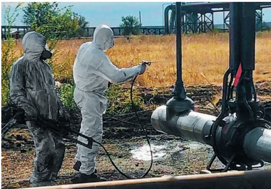
Изолировщики нанесли «Биурс ОС» на элементы обвязки камеры запуска внутритрубных устройств в Оренбурге в ходе комплекса ППР на газопроводе «Союз»
