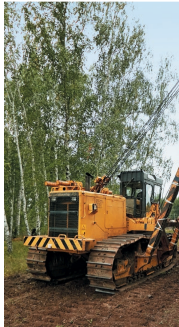
Машинисты трубоукладчика показали, как надо работать
