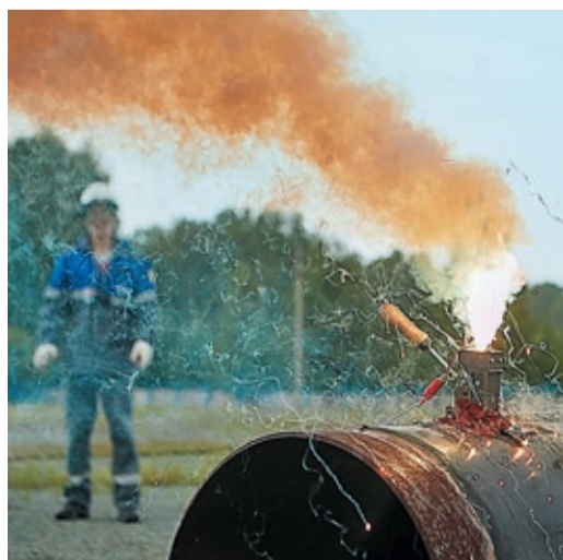
Конкурс монтеров ЭХЗ обязательно сопровождается «фейерверками»
