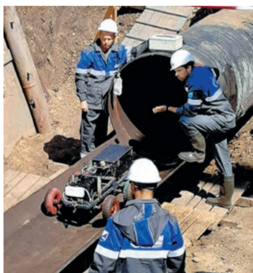
Вначале колесный робот пробрасывал трос, а затем с его помощью на другой берег протягивали внутритрубные поршни
