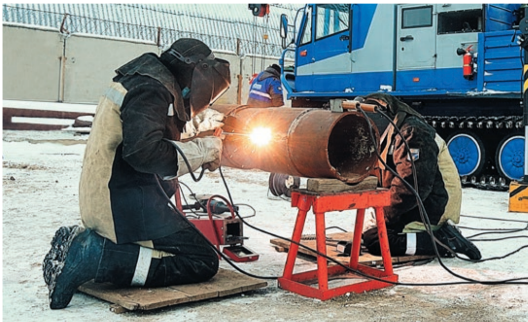
Для работы с трубами большого диаметра нужен «сварочник» на четыре-шесть постов
