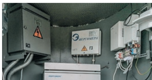
Блоки сбора и передачи данных устанавливают в укрытиях станций катодной защиты
