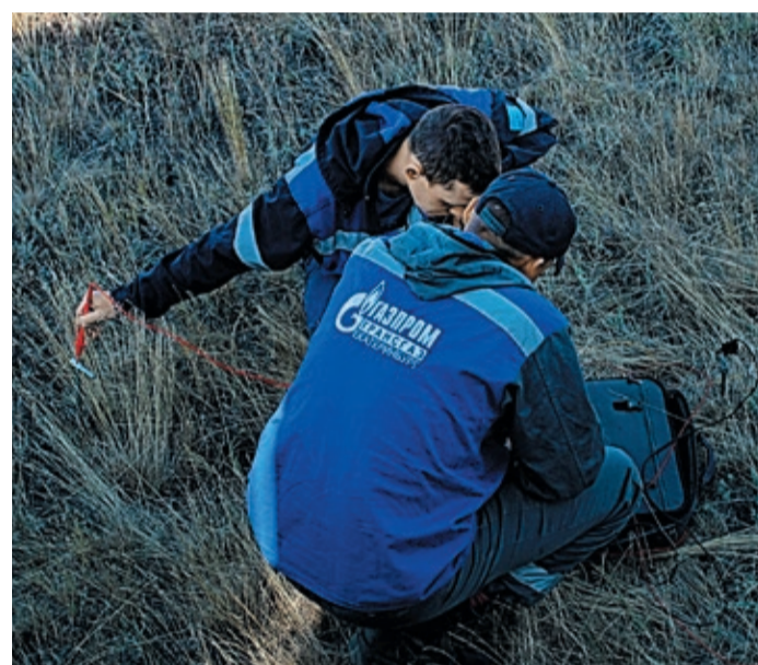
Чтобы правильно защитить трубу, нужно знать удельное сопротивление грунта
