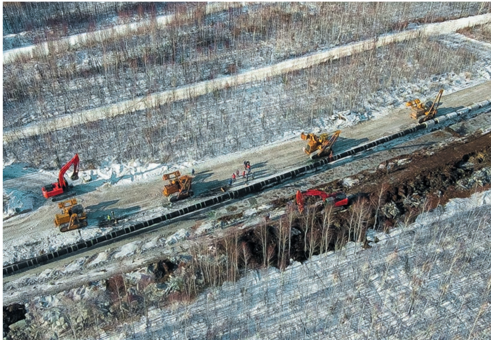
Обустройство переходов через водные преграды — один из самых сложных этапов строительства и ремонта газопроводов
