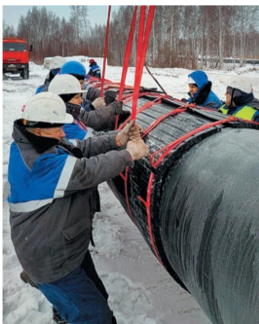
Полимерные профили предохраняют изоляцию трубы от повреждения бетонными пригрузами
