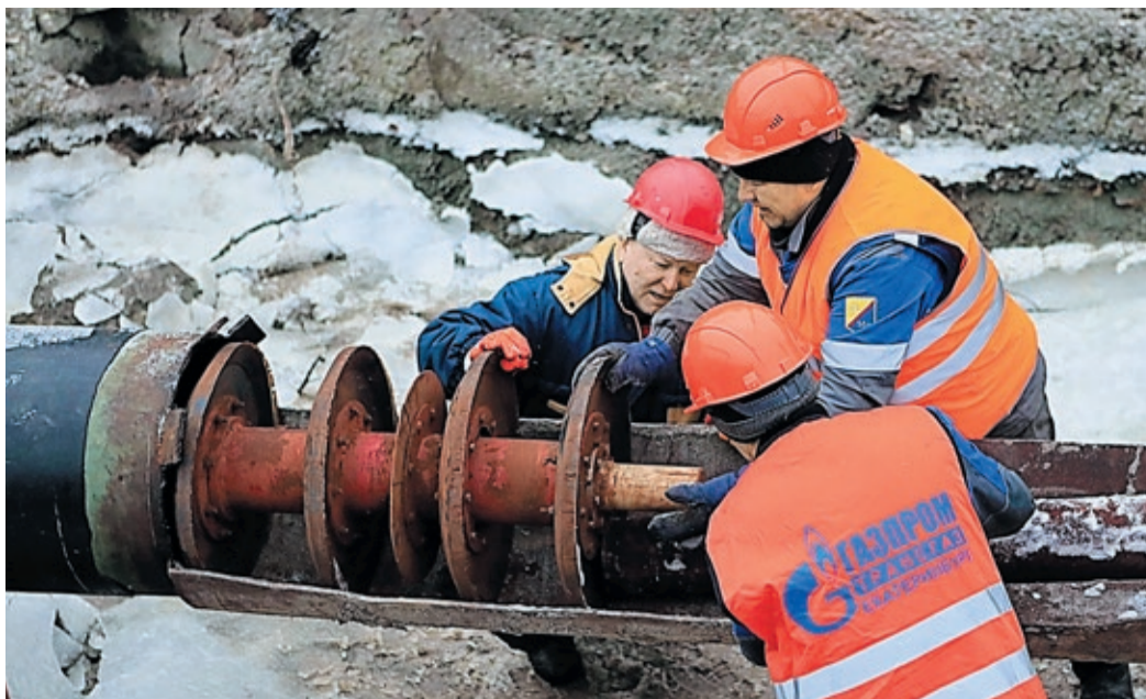
Первым в трубу запускают очистной поршень
