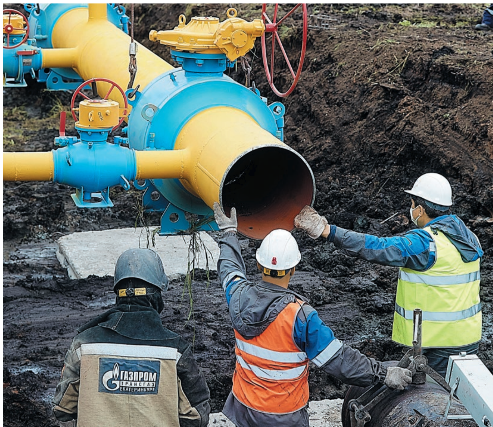
Для проведения обследования в газопровод часто врезают временные камеры приема и запуска внутритрубных устройств. Врезка в Малоистокском ЛПУМГ на отводе к ГРС-3 Екатеринбурга, шоль 2020 года
