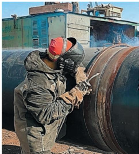
Полуавтоматическая сварка существенно ускоряет сборку плетей
