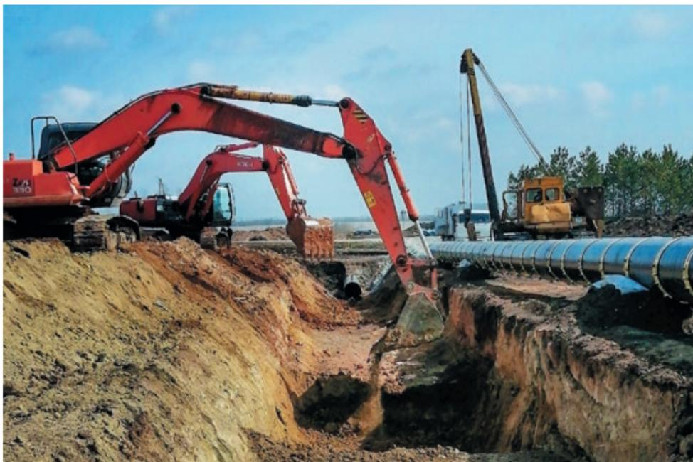
Перед укладкой в траншею трубу сваривали в плети длиной до трех километров
