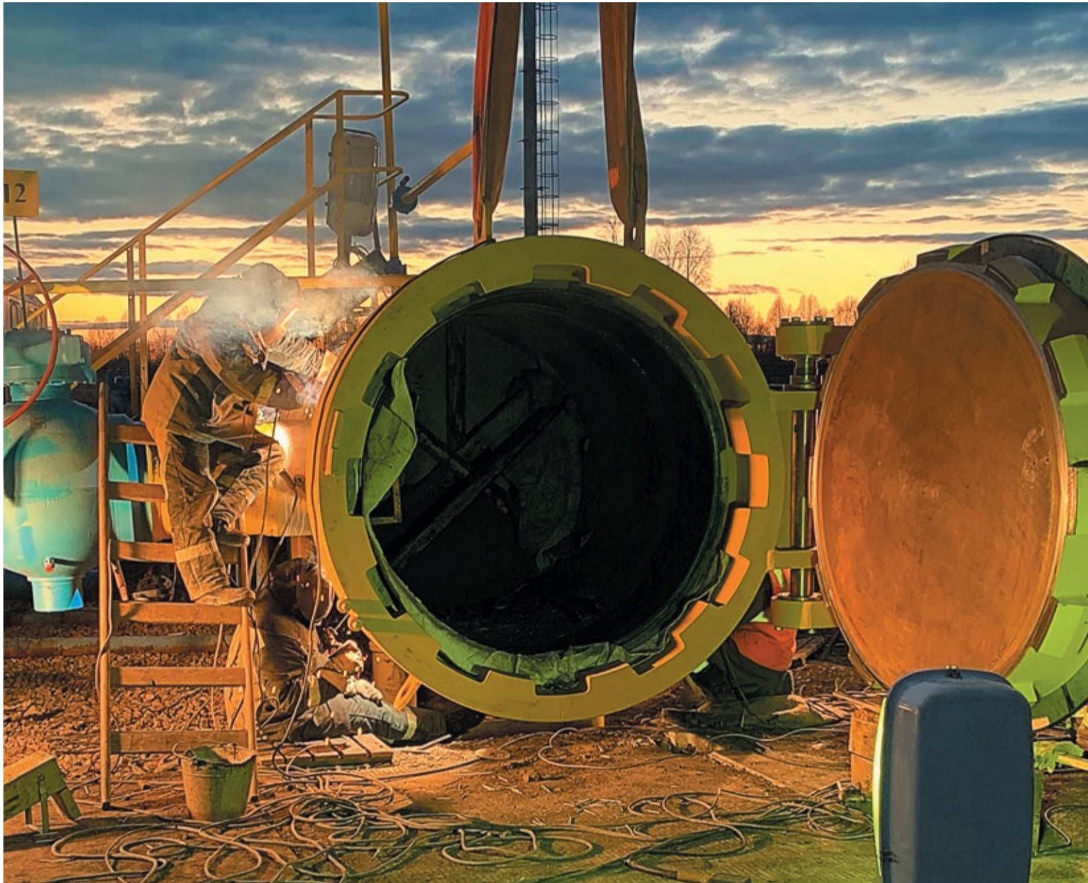
Затворы камер изготовлены из металла толщиной несколько сантиметров: чтобы приварить один, требовалось несколько часов, и сварщики, начав работу с первыми лучами солнца, заканчивали ее уже при искусственном освещении
