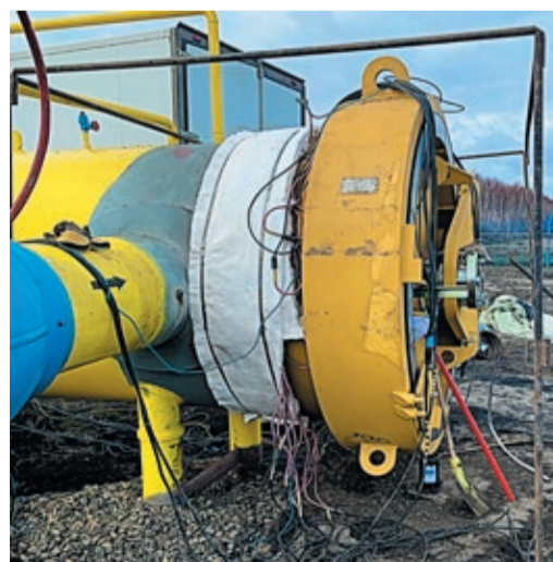
Для термообработки сварного стыка использовали «электроодеяло»
