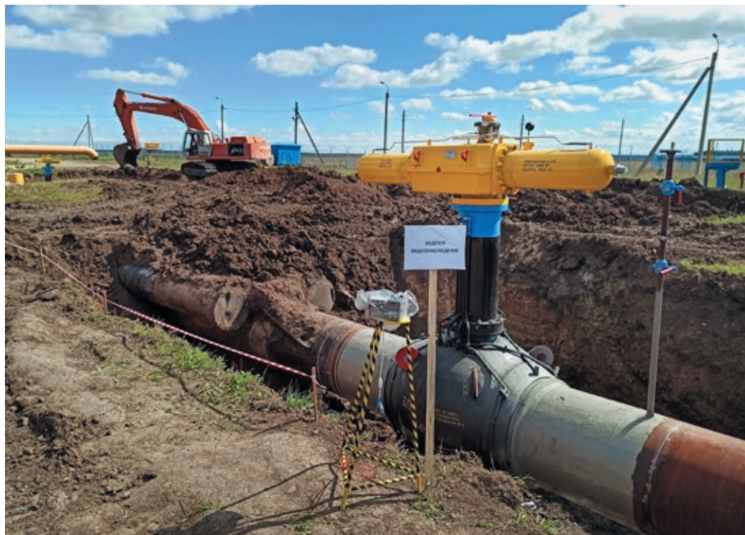
На домбаровской трассе также заменили шесть кранов диаметром 1200 мм
