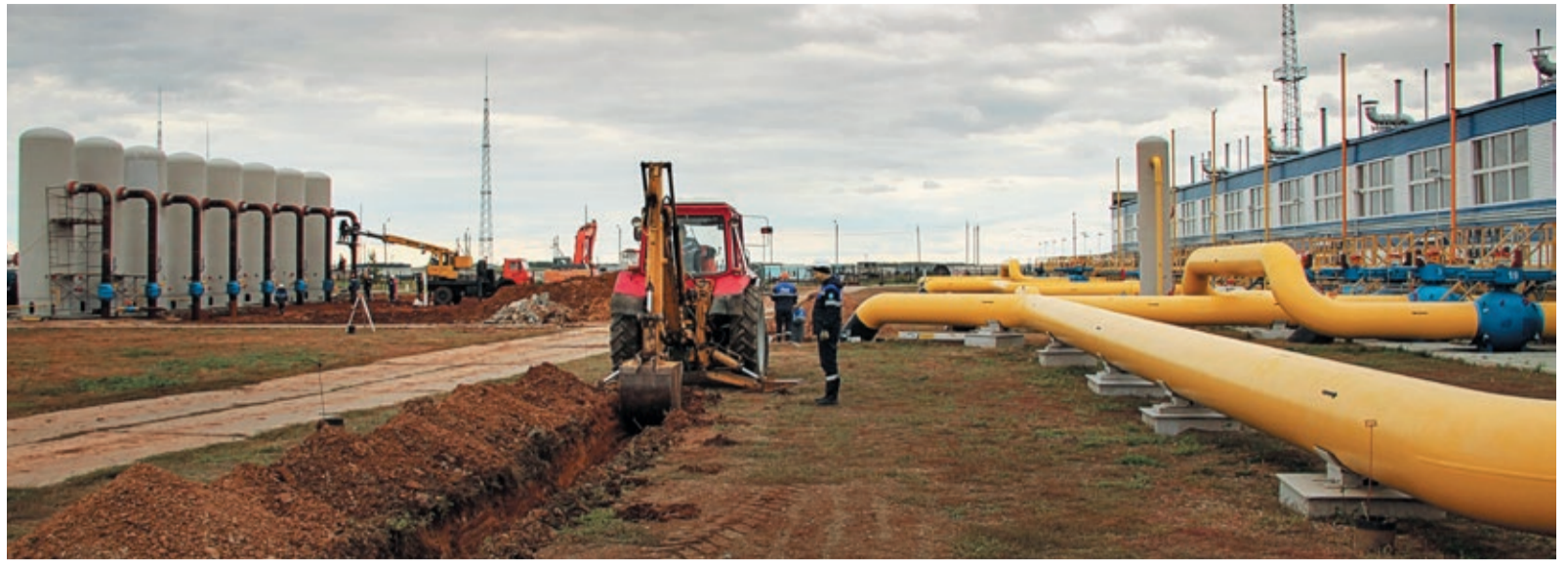
На КС-17 Карталинского ЛПУМГ вырезали старую запорную арматуру на подземных шлейфах и наружных нитках пылеуловителей
