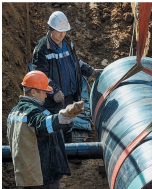
В работе была задействована бригада из 14 человек, включая водителей, машинистов трубоукладчиков и сварочной станции
