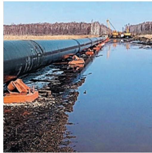
На южном берегу строителям приходилось постоянно бороться с грунтовыми водами
