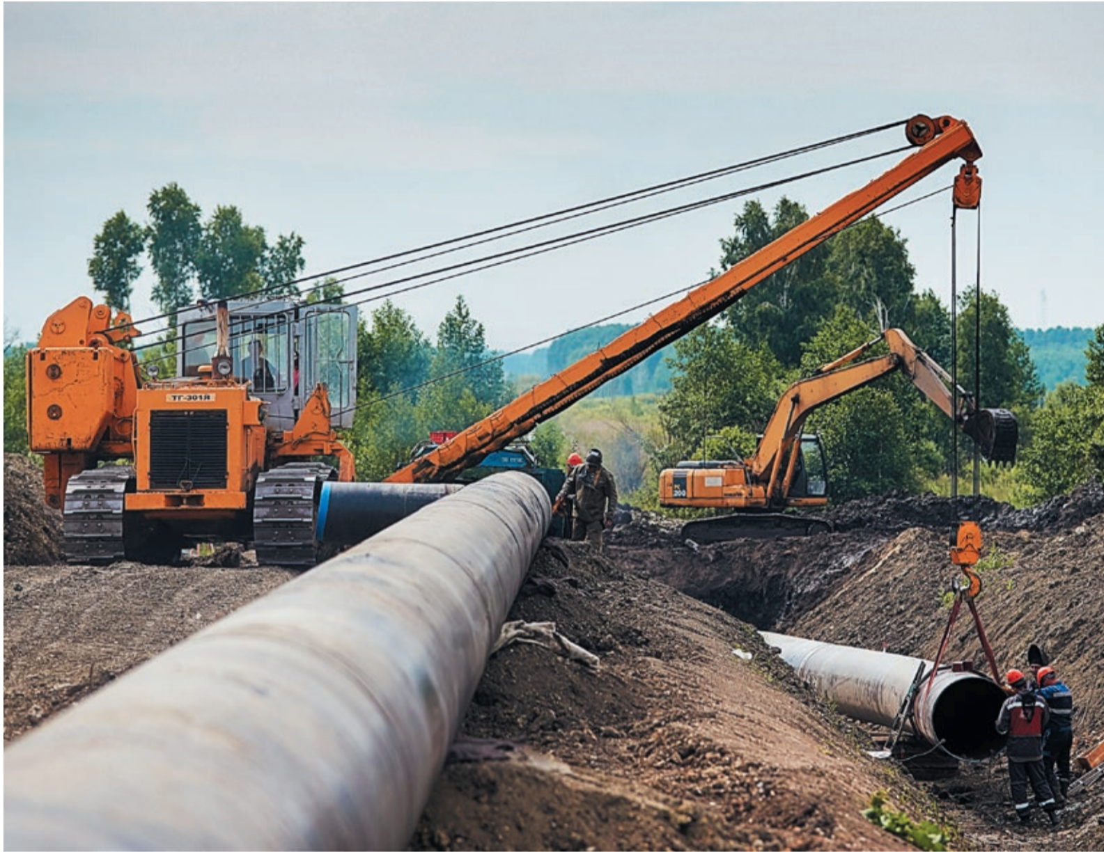
Капитальный ремонт подводного перехода через реку Теча в Челябинской области был проведен в соответствии с требованиями Газпрома и Росатома
