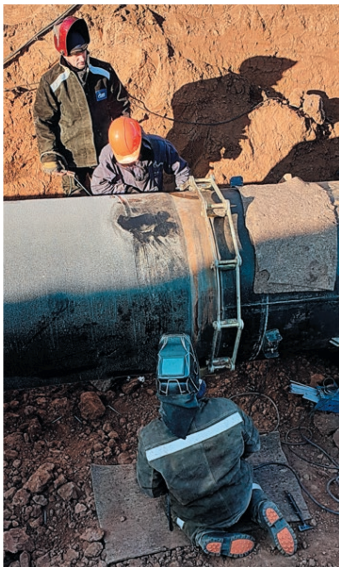
Катушку метрового диаметра врезают работники Домбаровского ЛПУМГ: (сверху вниз) Виктор Михайлов, Евгений Попов и Андрей Мишук
