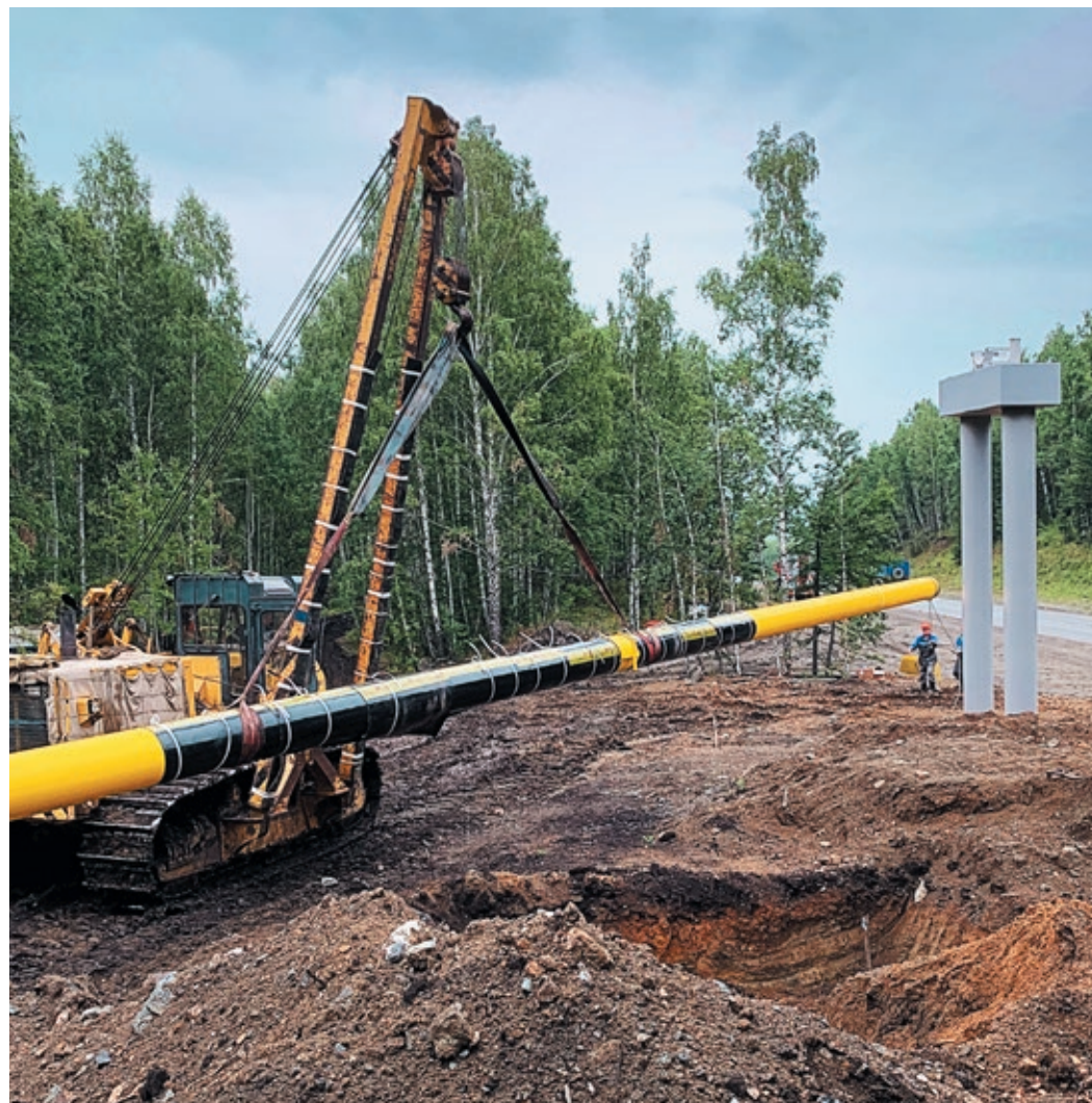
33-метровую плетть заранее сварили и испытали, прежде чем перекинуть над дорогой
