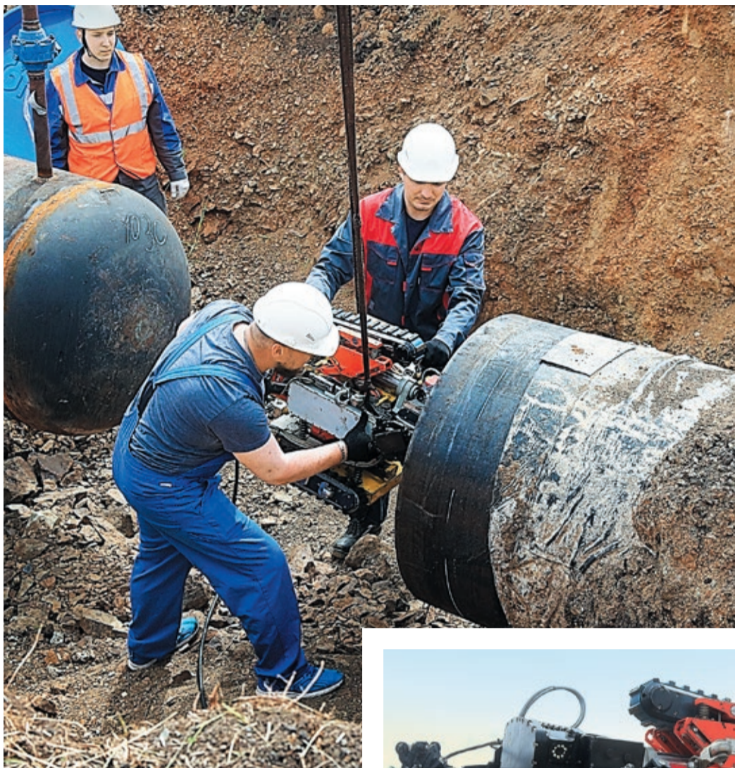
Там, где подъемный кран не мог подъехать, «крота» в трубу устанавливали вручную
