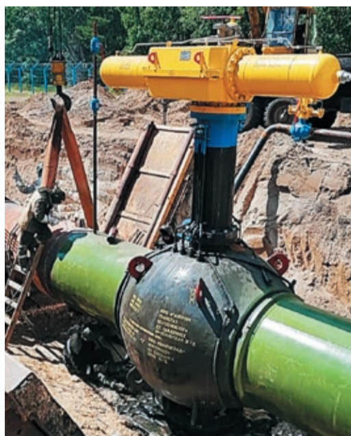
Кран в песчаном грунте — редкость для Зауралья
