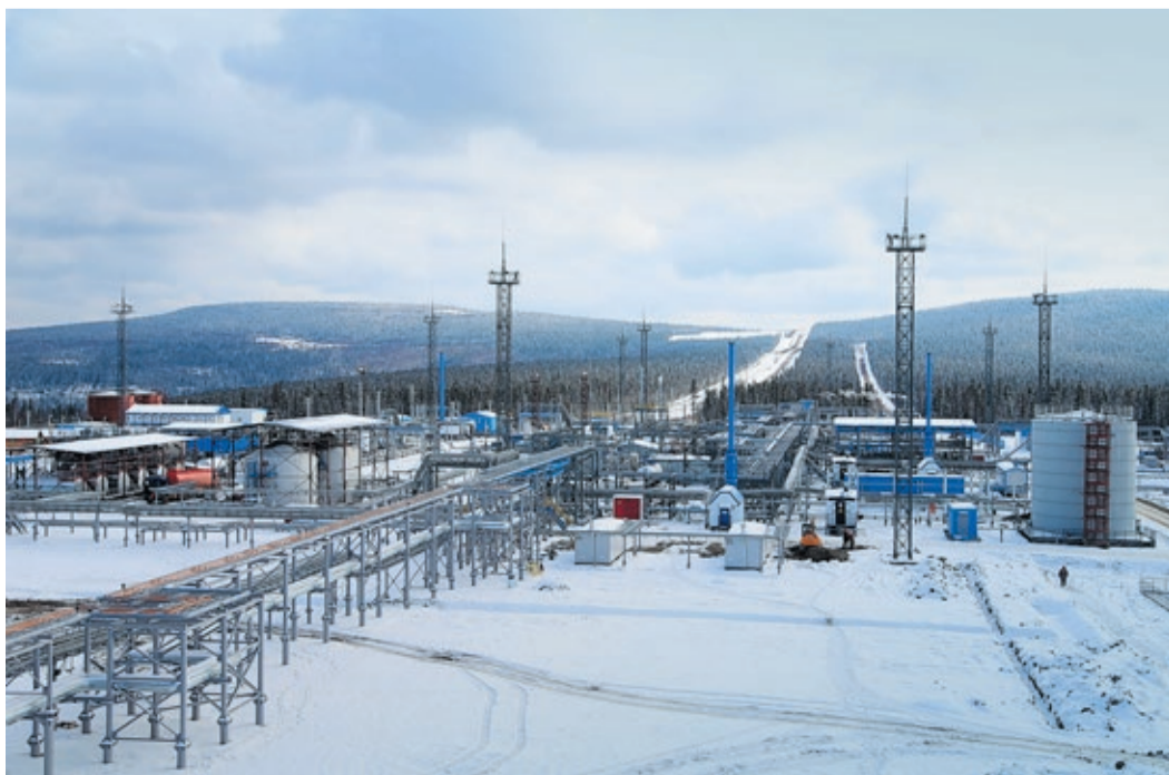
Установка подготовки газа УПГ-102 на Ковыктинском месторождении
