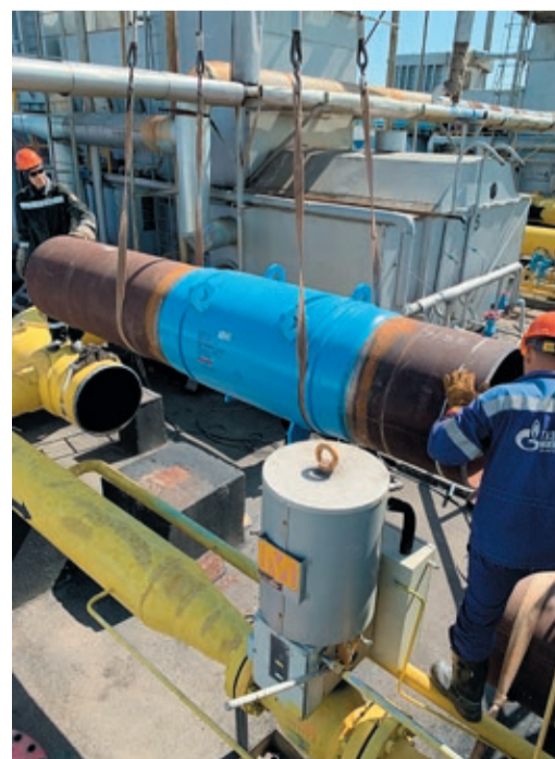
На пятом агрегате установили новый кран и обратный клапан
