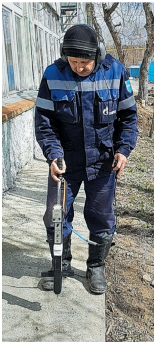
Найти повреждение Сергею Жаринову помогают генератор, «рамка» и музыкальный слух
