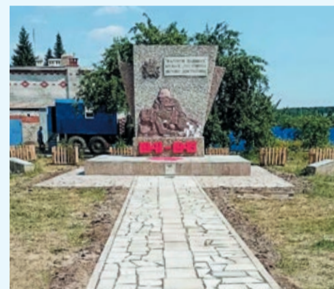
...а челябинские ремонтники сделали отмостку гранитной плиткой
