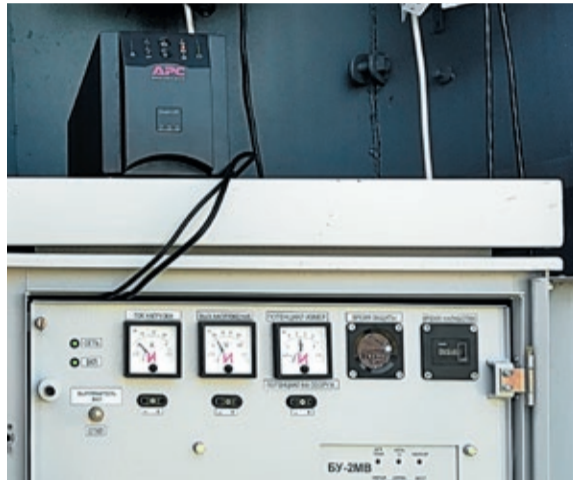
Благодаря смекалке катодников для защиты газопровода использовали офисную технику
