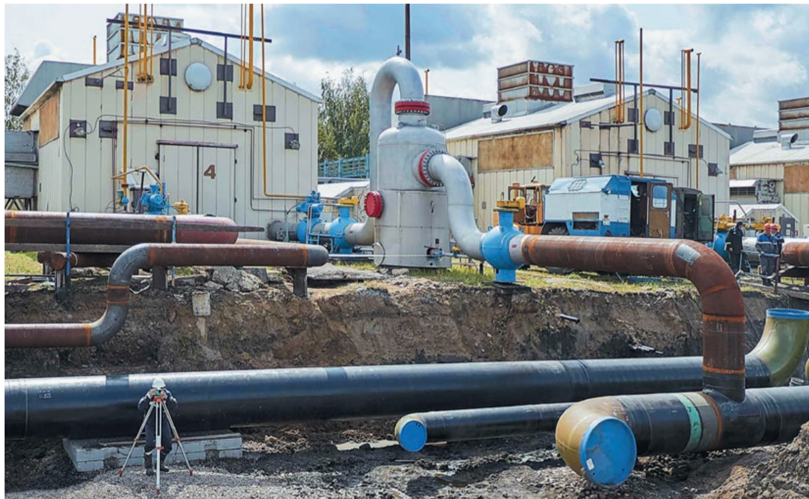
Стальной лабиринт технологической обвязки компрессорного цеха № 1 Далматовской ГКС испытали на прочность, применив метод противодействия
