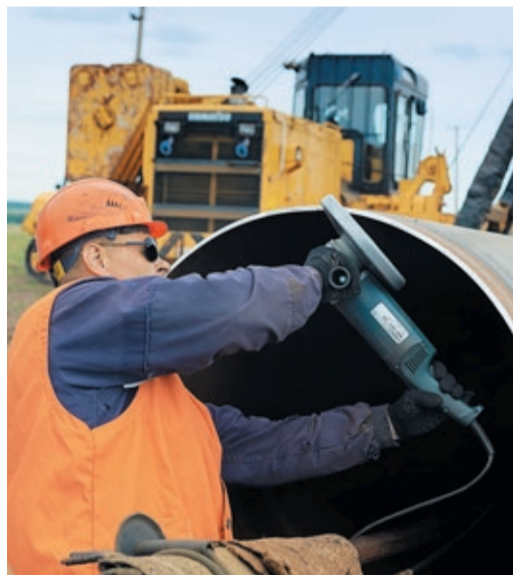
Несмотря на пандемию, темпы работ на магнитогорском отводе даже выше, чем в прошлом году
