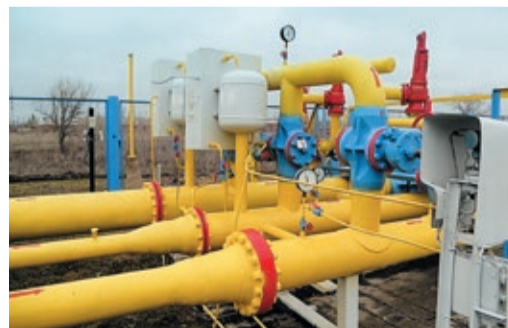
В ходе капремонта на станции «Бузулук» меняют все трубопроводы и основные узлы
