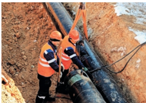
Хотя мартовское солнце светит ярко, в траншее еще холодно
