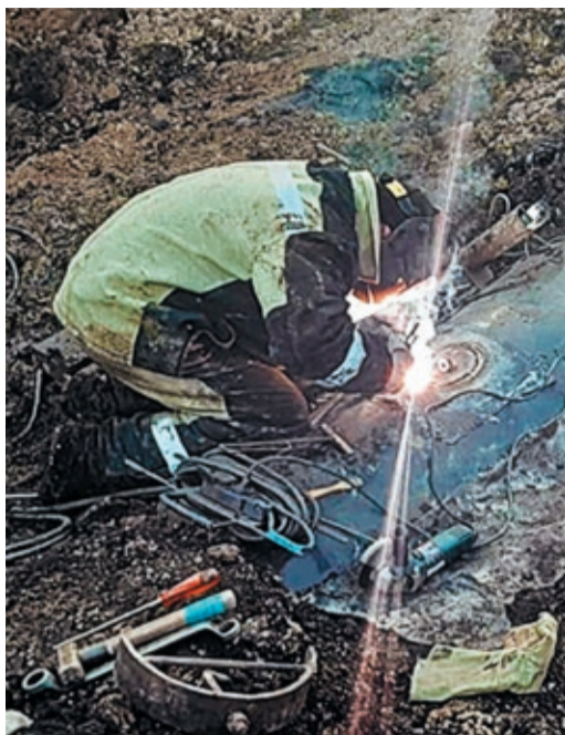
В ходе комплекса шадринские сварщики вырезали шесть «окон»
