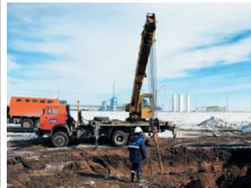
При реконструкции применяется более прочная труба
