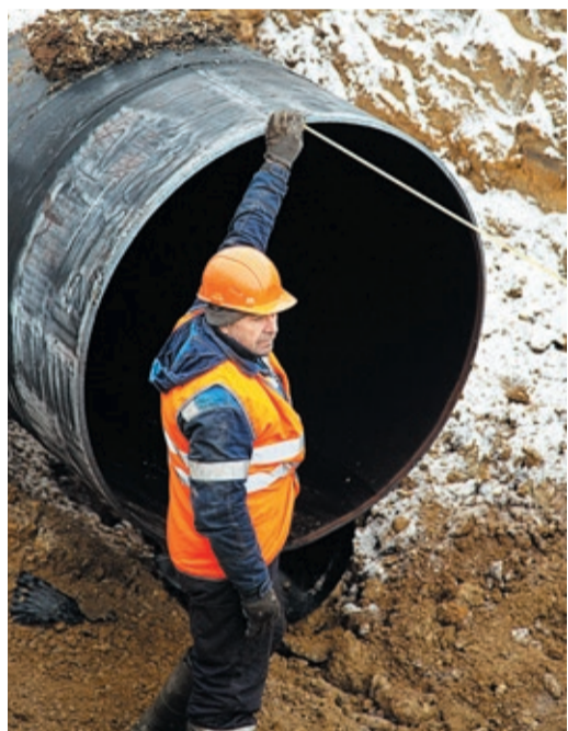
Далматовцам помогает монтажник УАВР № 3 Петр Комаров
