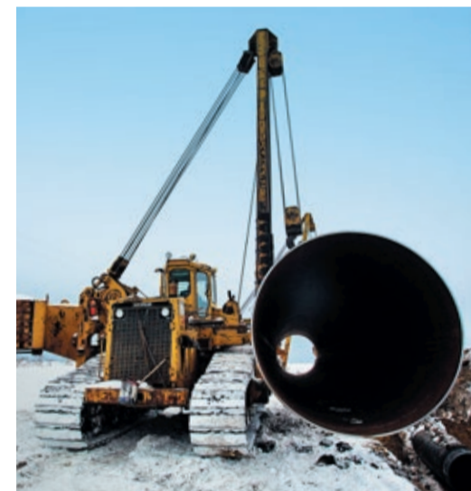
Тяжелая техника из автопарка управления аварийно-восстановительных работ
