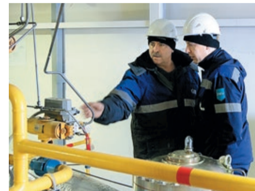
В Невьянске самарцам показали турбодетандеры, которые полностью обеспечивают ГРС электричеством
