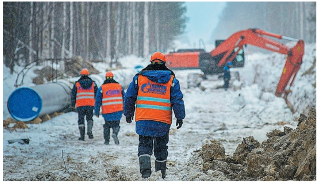
Основные ремонтные работы в январе-феврале ведутся на магистральных газопроводах
