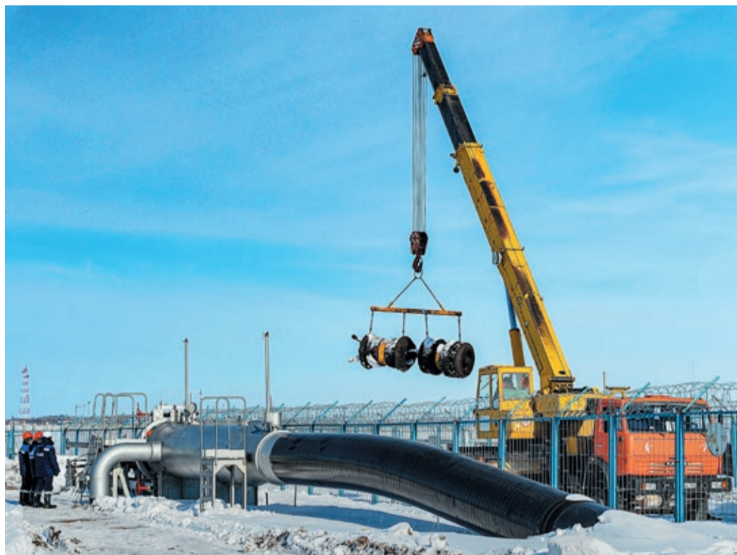
В минувшем году чаще всего внутритрубные дефектоскопы пропускали по магистральному газопроводу «Бухара — Урал»
