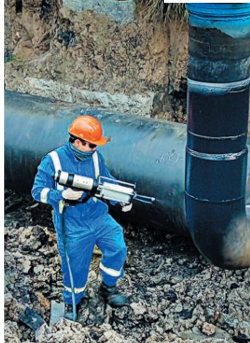
Жидкие покрытия удобно использовать для изоляции тройников, отводов и других фасонных изделий
