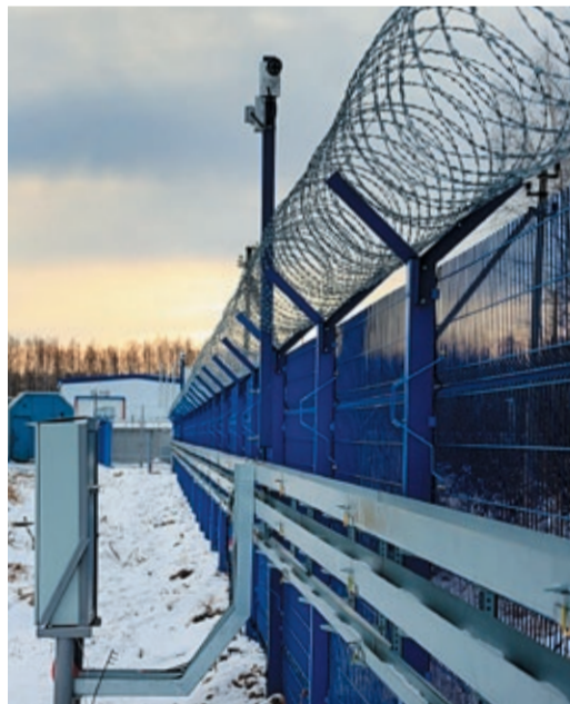
Это уже не просто забор, а инженерно-техническое средство охраны, оснащенное разнообразными датчиками и камерами
