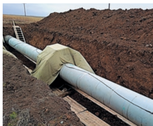
Уровень адгезии изоляции к трубе проверяли в «палатке», где воздух нагревали до +15 градусов
