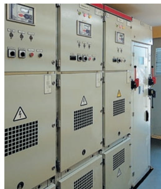
Оборудование смонтировали работники службы энергоснабжения
