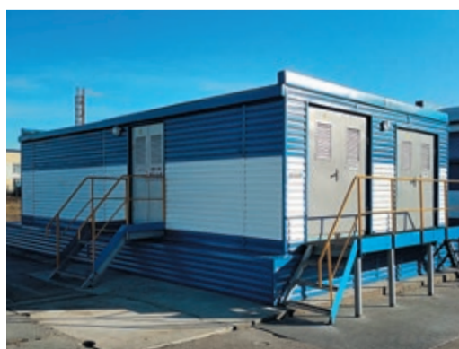
Подстанцию на промплощадке в поселке Голубой Факел отремонтировали внутри и снаружи
