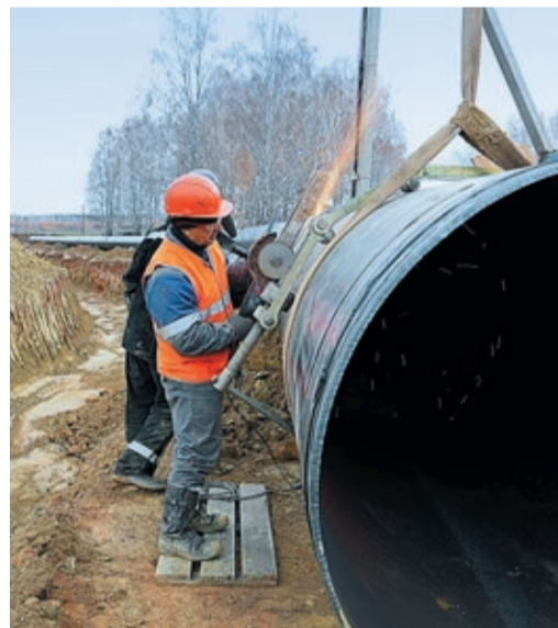
Монтажник зачищает стык, и у сварщика есть пара минут на передышку
