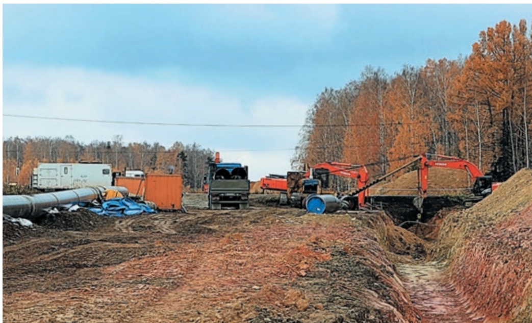
В октябре самый протяженный участок магистрали отремонтировали в районе старотюменского тракта
