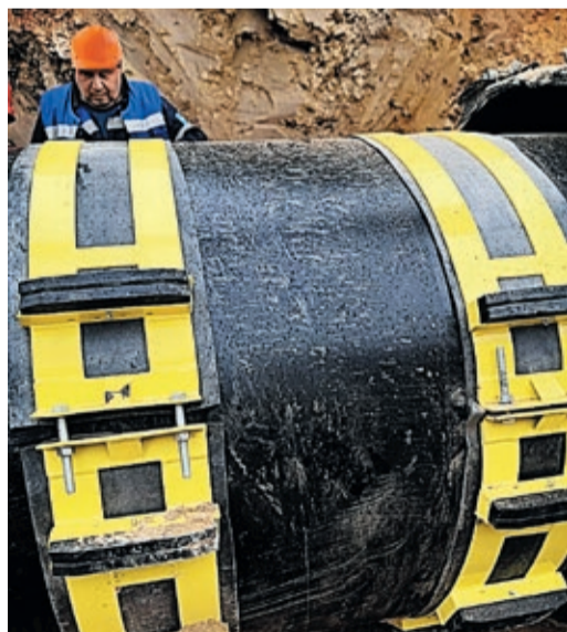
Для запаски трубы в патрон применяют опорно-направляющие кольца
