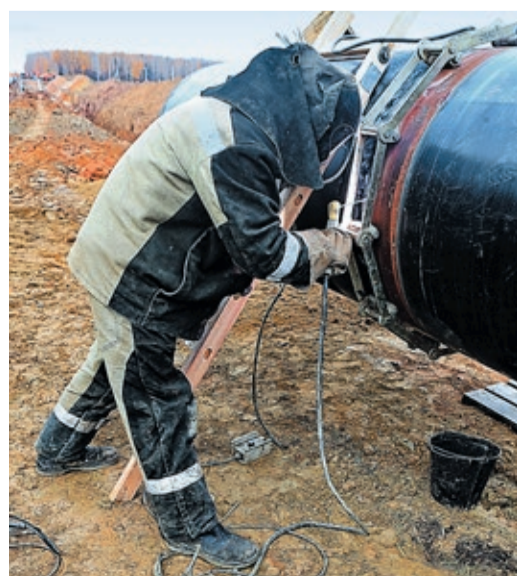
Пока труба зафиксирована центратором, ее сажат на прихватки
