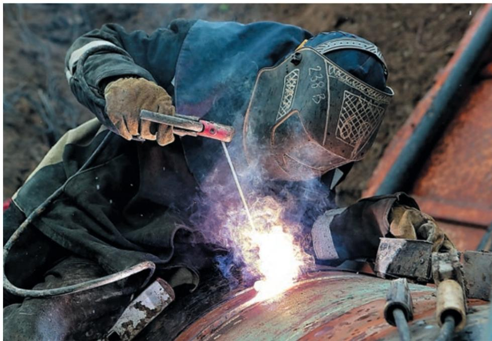
После гидроиспытаний ремонтники УАВР № 1 врезали новые катушки, соединив отремонтированный участок с входными шлейфами
