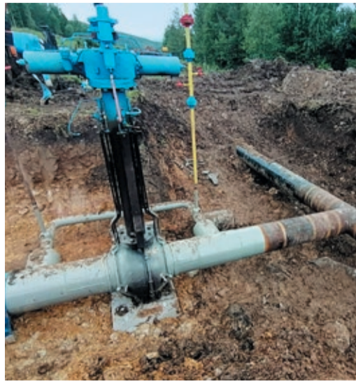
Новый тройник и кран красногорцы с УАВР № 2 устанавливали меньше суток
