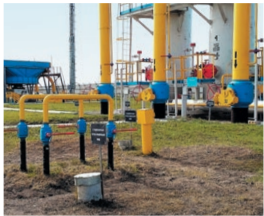
Краны небольшого диаметра на КС «Красногорская» заменили без привлечения УАВР
