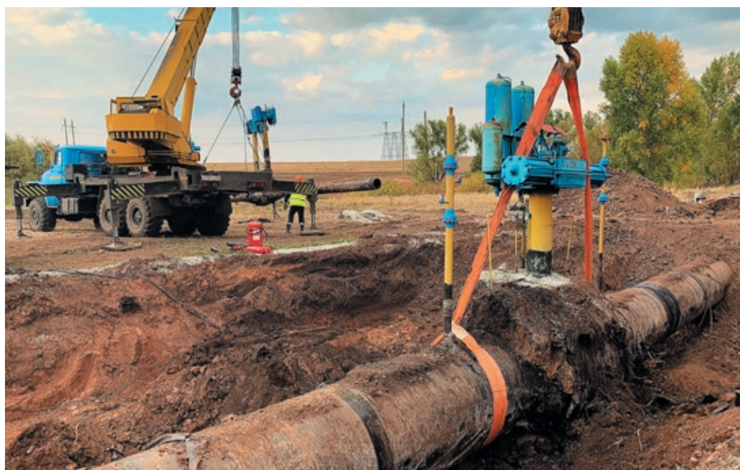
Самые масштабные работы в ходе комплекса ППР прошли на МГ «Домбаровка – Оренбург»
