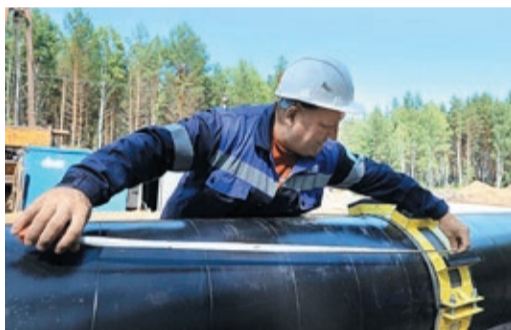
Расстояние между опорными «кольцами» выверено до сантиметра
