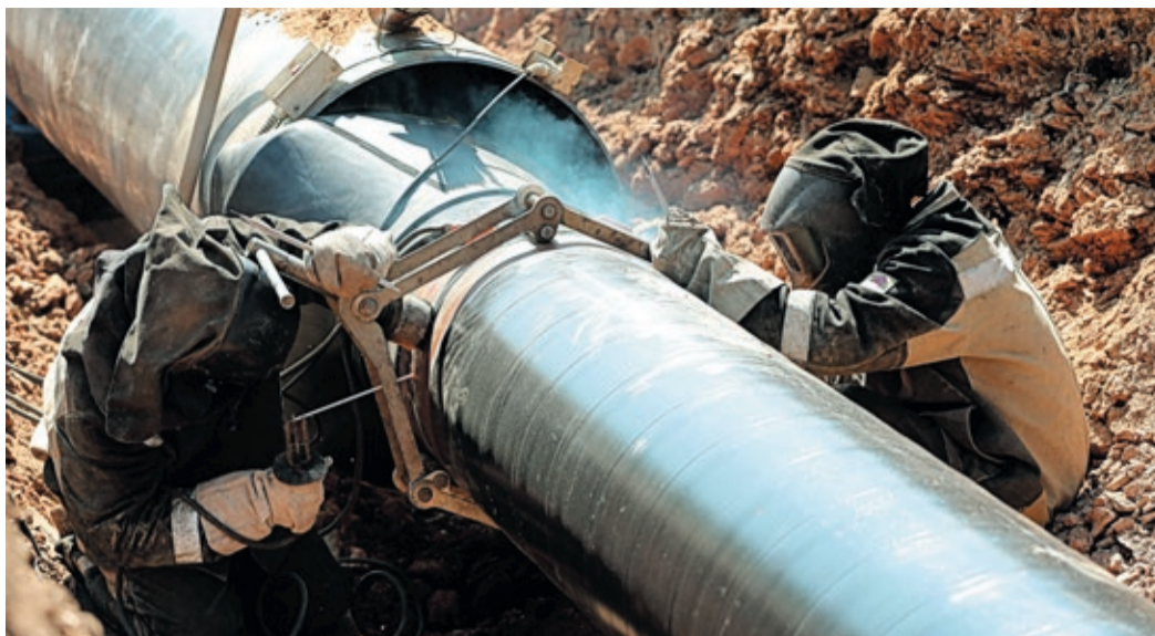
После запасовки в футляр трубу наращивают, приваривая новые плети
