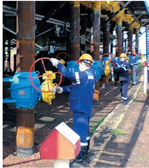
Ремонт на Саракташской ГКС закончен – идет продувка контура
