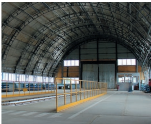
Пункт технического контроля разместился в помещении бывшего склада, его полностью отремонтировали хозспособом
