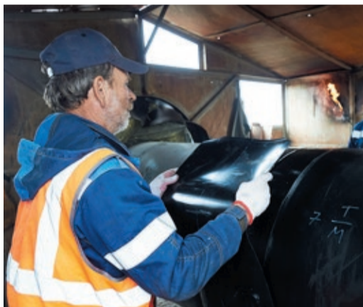
Новая труба надежно прикрыта заводской изоляцией, но стыки зачищают и защищают изоляровщики УАВР
