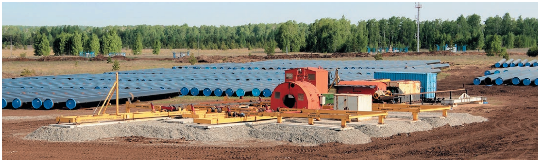
Масштабы ремонта: на временных трубосварочных базах работники УАВР № 2 сварили более тысячи плетей «двухтрубок»
