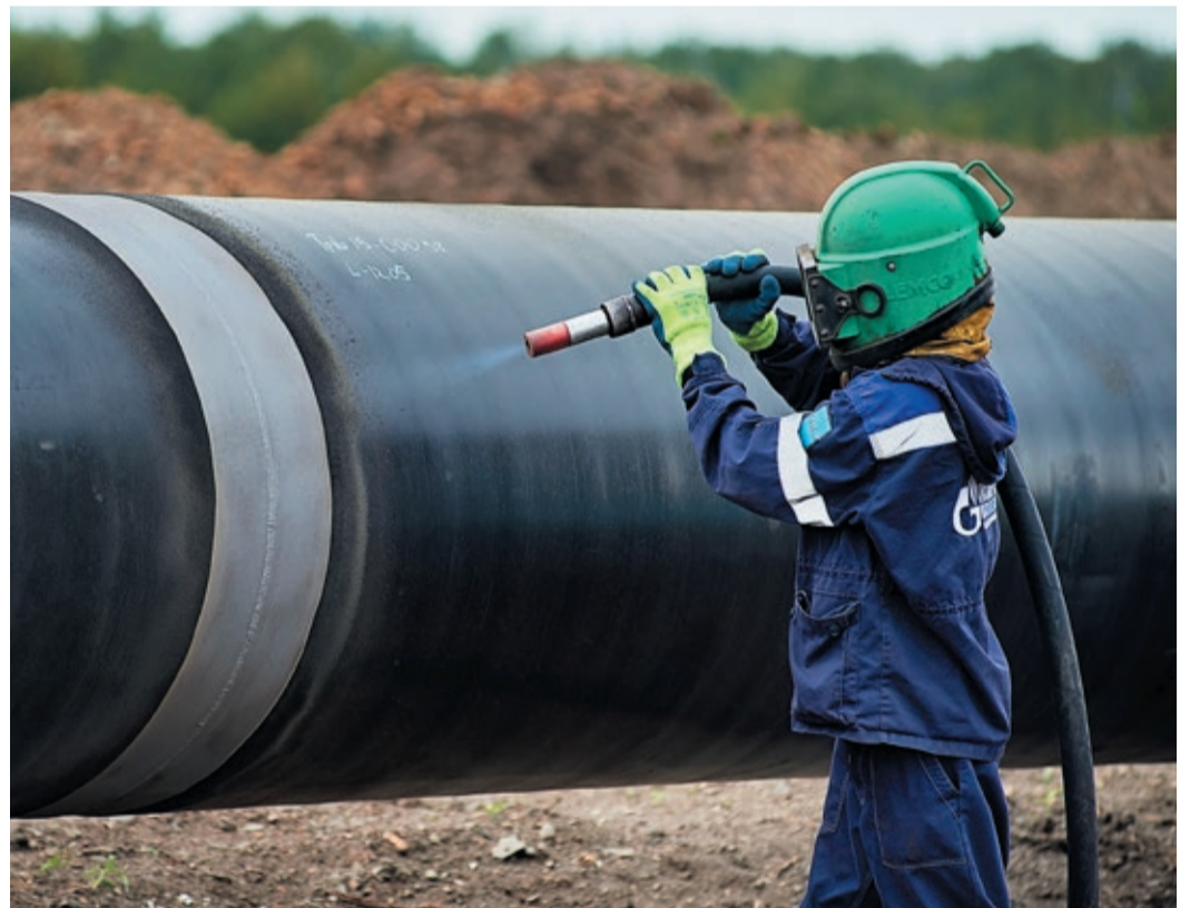
Новая труба надежно прикрыта заводской изоляцией, но стыки зачищают и защищают изоляровщики УАВР
