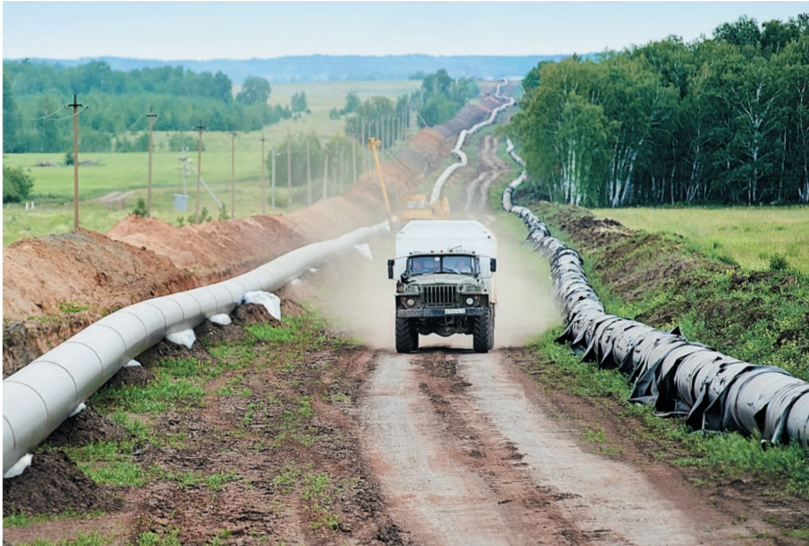
Самый масштабный в этом году ремонт газопровода уверенно приближается к своему завершению
