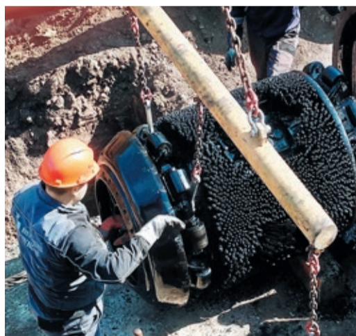
Бузулукские линтубы снаряжают дефектоскоп в дороге
