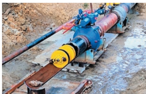
Отвод на Курган обследуют с помощью временных камер приема/запуска
