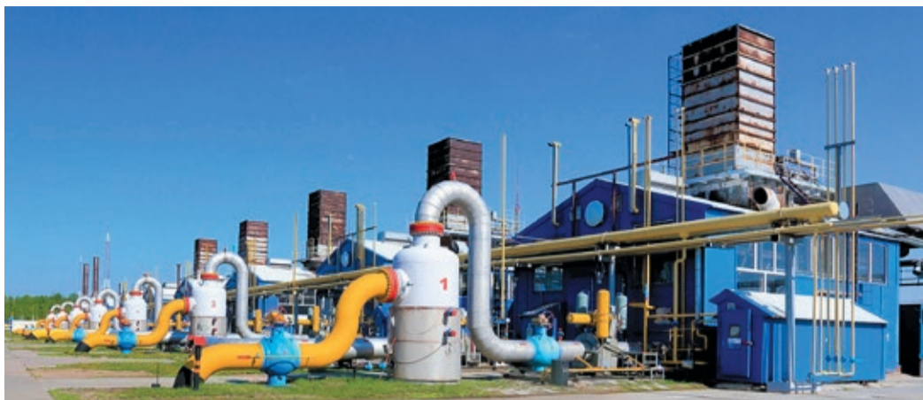
На Шатровской ГКС проверили газоочистители-скруббера агрегатов первого цеха
