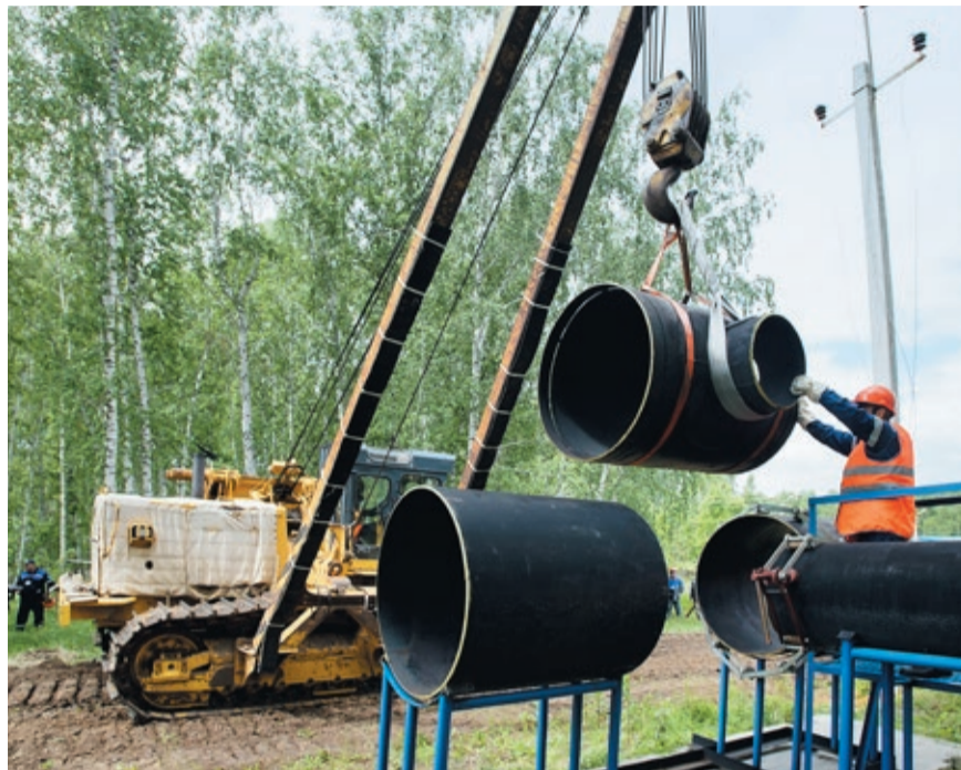
Во время конкурса машинисты выполняли свою повседневную работу: монтаж тройника и перевозка трубы к месту ремонта
