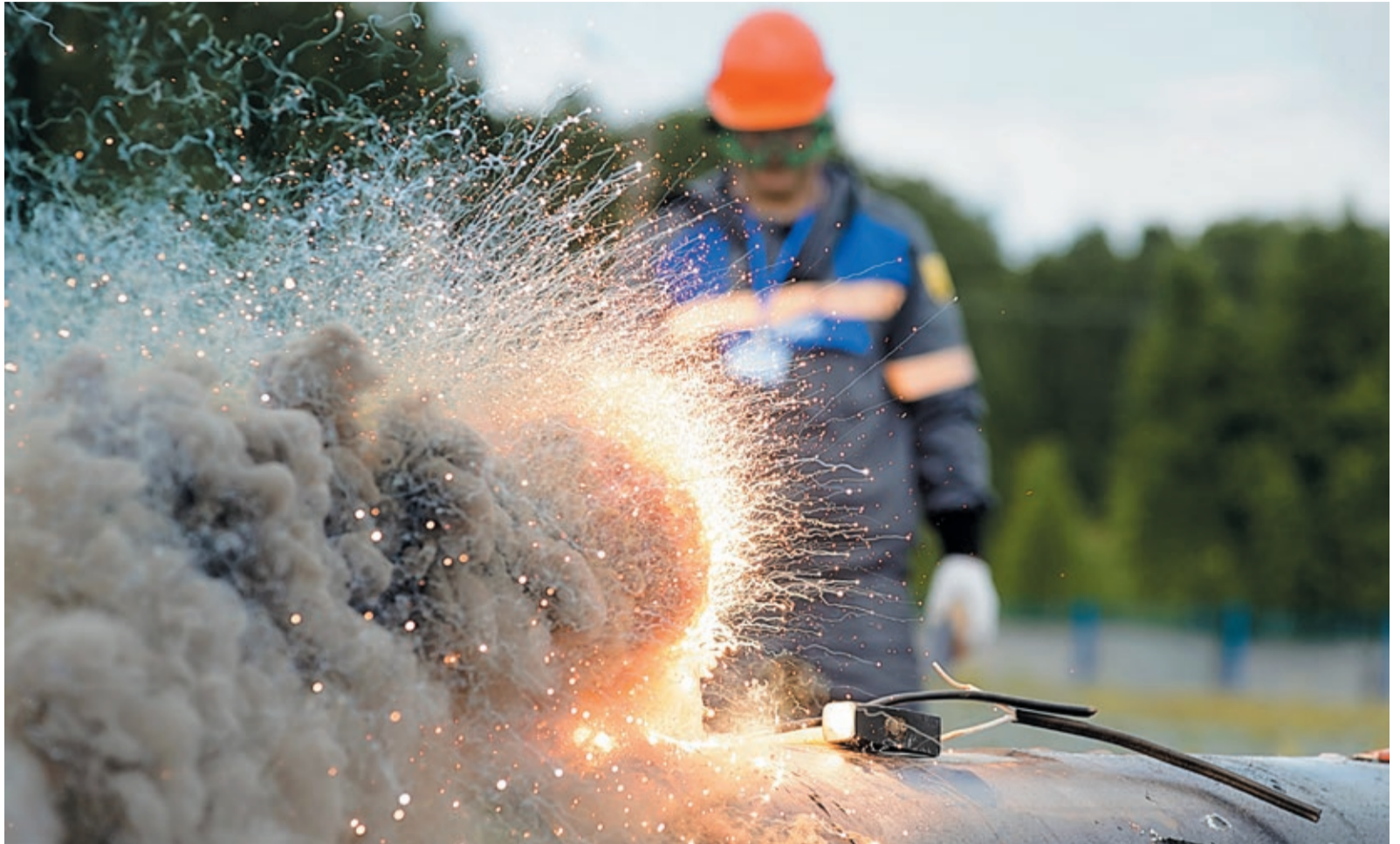
Во время термитной приварки монтер отходит на безопасное расстояние
