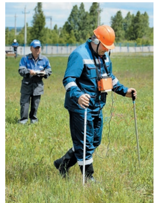
С помощью электродов ищут повреждения изоляции
