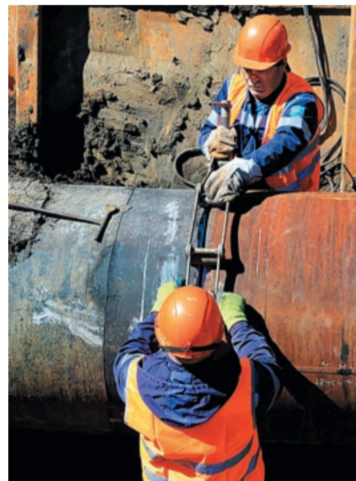
Всего было установлено около десяти катушек метрового диаметра
