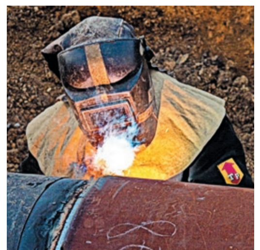
Установка муфты под силу только самым опытным сварщикам и монтажникам
