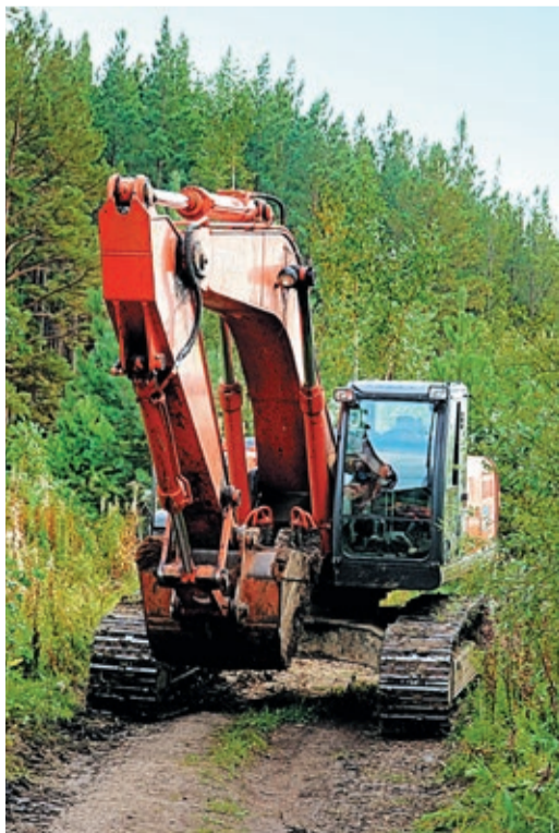
На первоуральском отводе сделали семь шурфов
