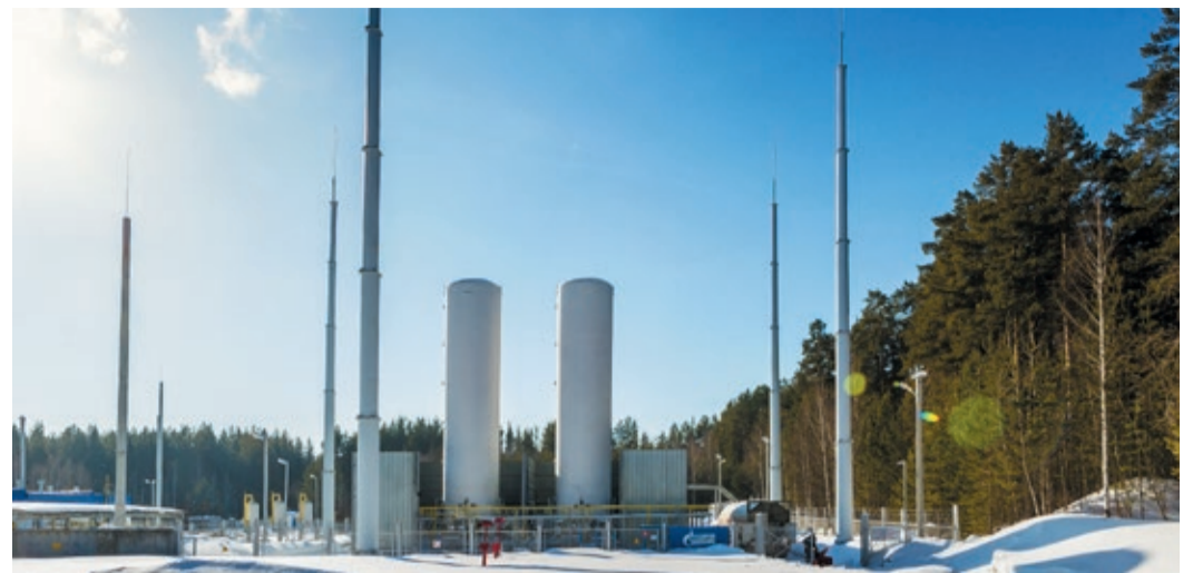
Криогенная емкость одновременно является грузоприемным устройством СПГ-весов и тарой для его хранения
