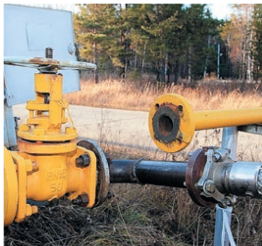
Комплекс из цистерны СПГ и регазификатора можно подключить к ГРС или напрямую к распределительной сети поселка
