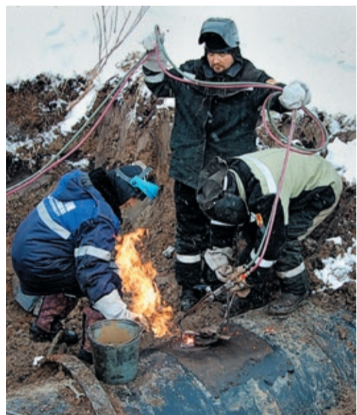
На огневых работах линтубы Далматовского ЛПУМГ
