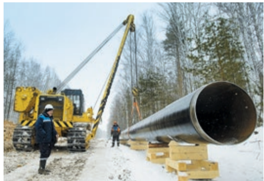
Работники УАВР № 4 капитально отремонтировали 430-метровый участок МГ «Свердловск – Сысерть»
