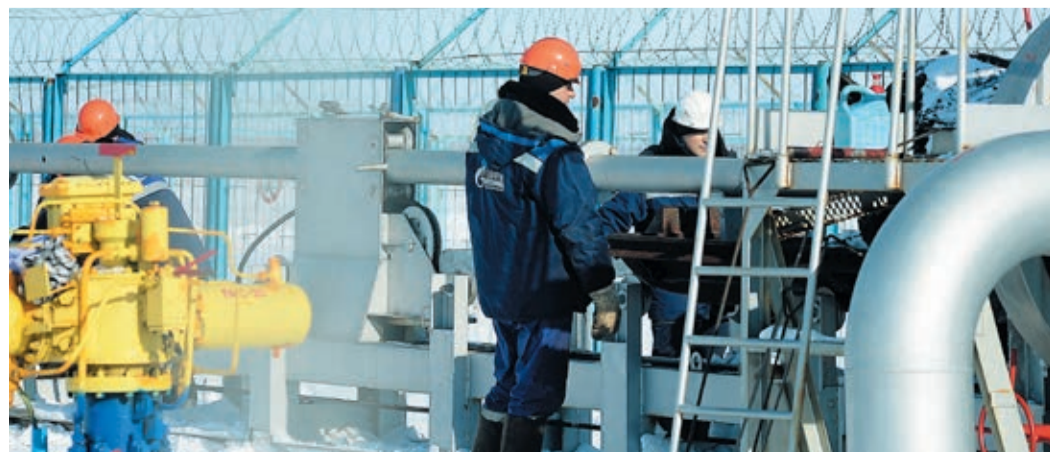
Внутри камеры запуска поршень проталкивают с помощью специальной штанги
