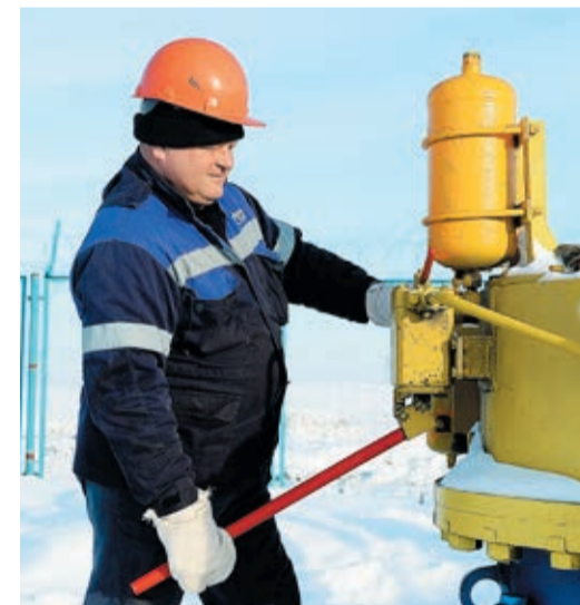
Как только кран откроется, поток газа направит поршень в трубу
