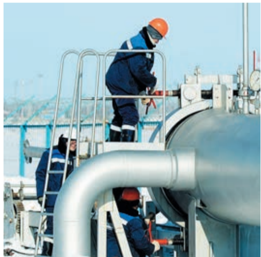
Снаряд загружен, и линтробы тщательно запирают камеру запуска
