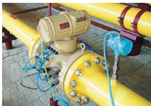
Средства измерений в УРМЦ поверяют на природном газе высокого давления
