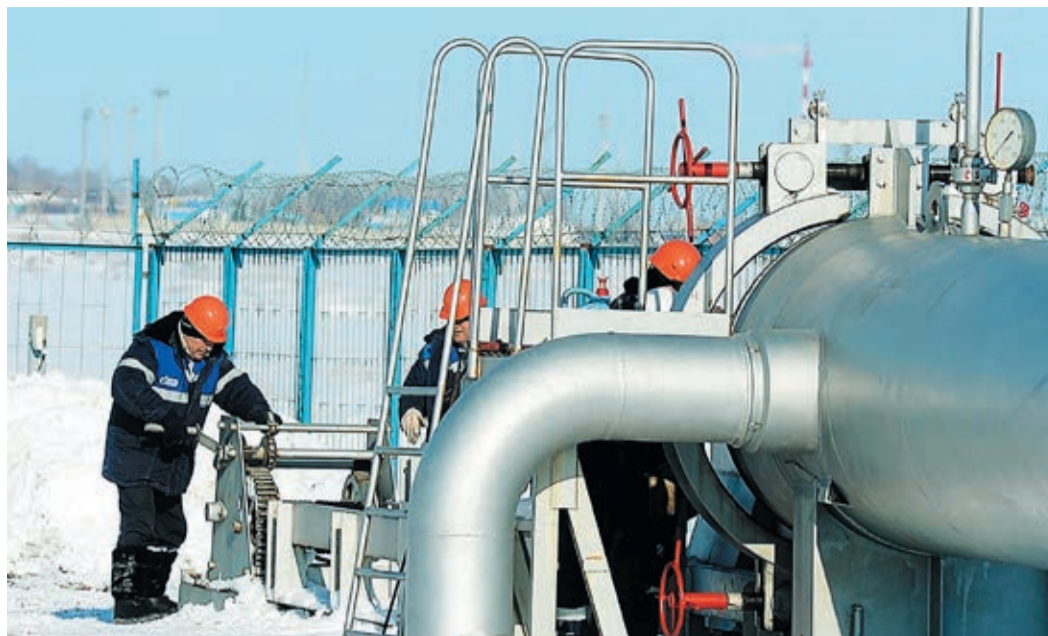
Загрузочный механизм приводит в действие простая ручная лебедка
